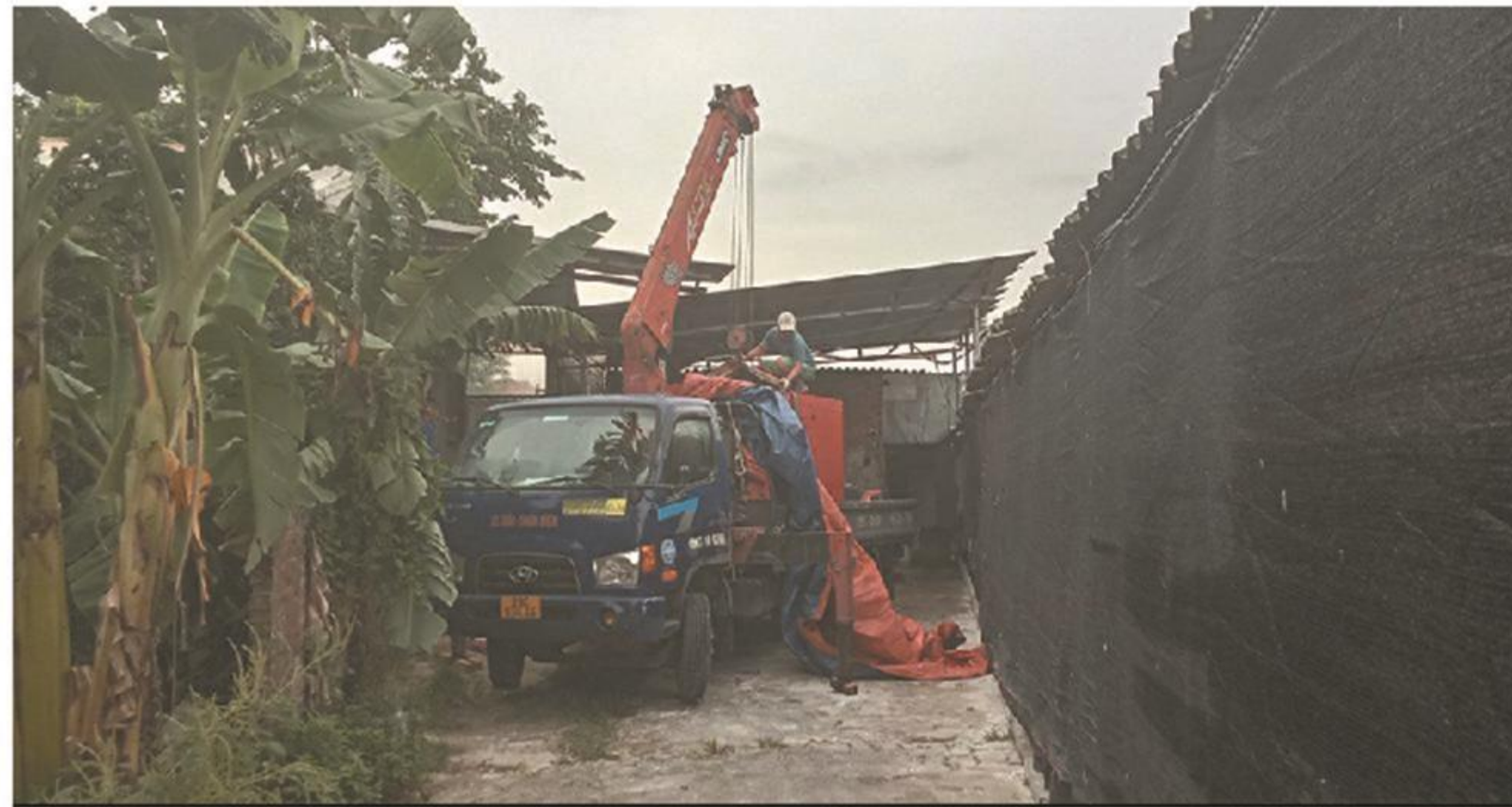
CÔNG TY TNHH ĐIỆN TỬ JIN XINFENG VIỆT NAM SHANGCHAI 125kVA
