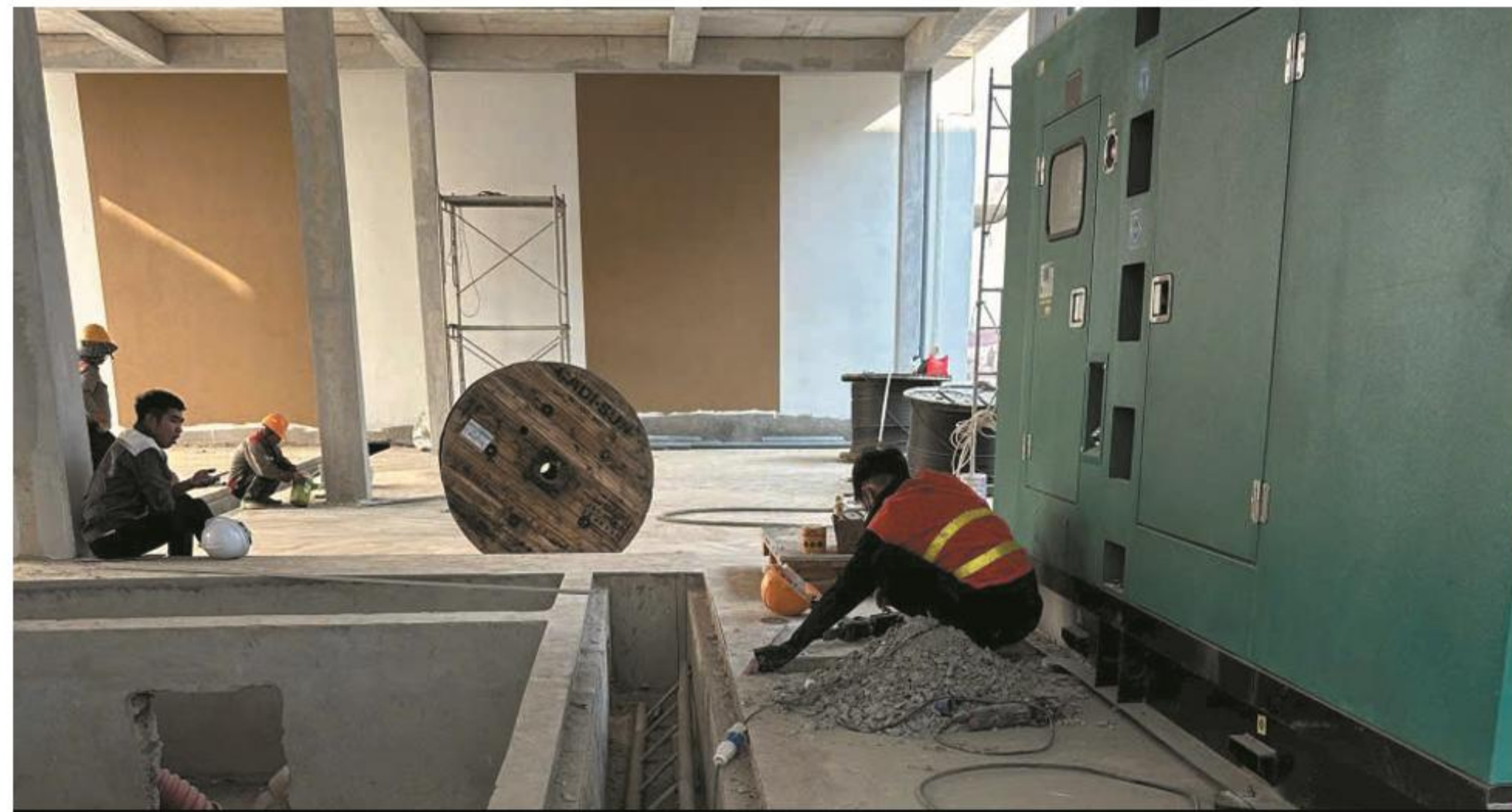
CÔNG TY TNHH KỸ THUẬT VÀ DỊCH VỤ HÙNG PHONG YUCHAI 250kVA
