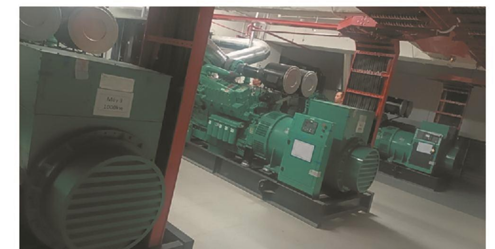
Công ty TNHH Điện tử Inventec CUMMINS 1250kVA*3
